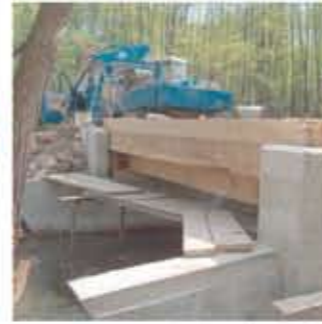
Neubau einer Brücke über den Otterbach
