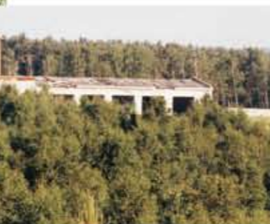
Einer der vielen Garagen- und Werkstattkomplexe
