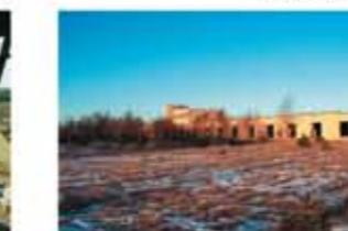
Eine der im Jahr 2005 und 2004 abgerissenen 4 großen 120 m langen und 12 m hohen Panzerhallen
